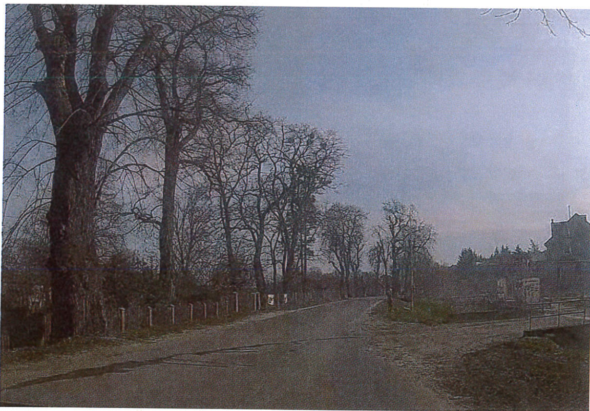
Zdjęcie nr 2 – widok na jezdnie w kierunku m. Silna – widoczny nieutwardzony zjazd z przepustem
