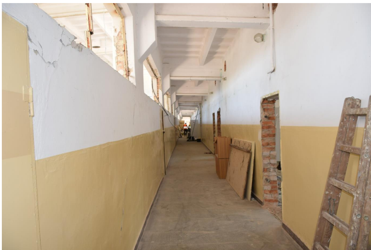
Zdjęcie 6. Prace Remontowe stan na dzień 22.09.2020 - budynek warsztatów CKZiU ul. Marcinkowskiego.
