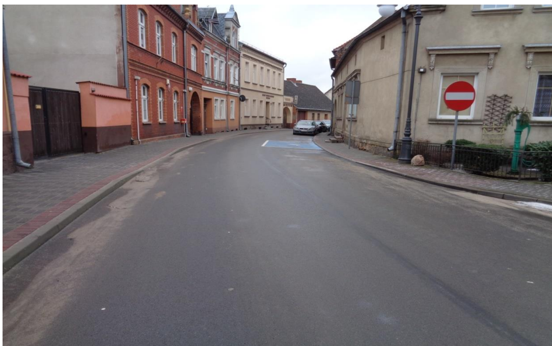
Zdjęcie 14. Remont drogi powiatowej nr 1332F w m. Pszczew – ul. Poznańska
