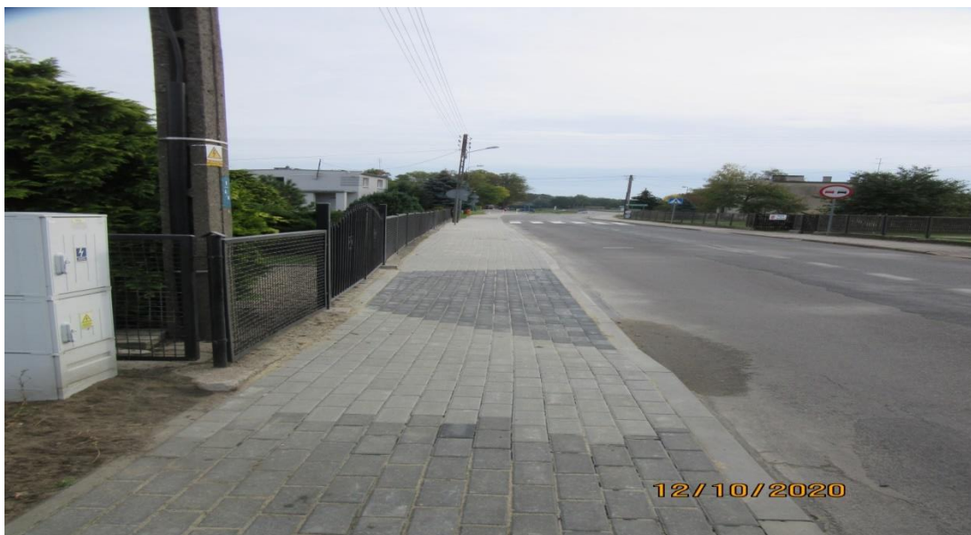
Zdjęcie 19. Przebudowa drogi powiatowej nr 1295F w m. Bledzew ul. Sportowa
