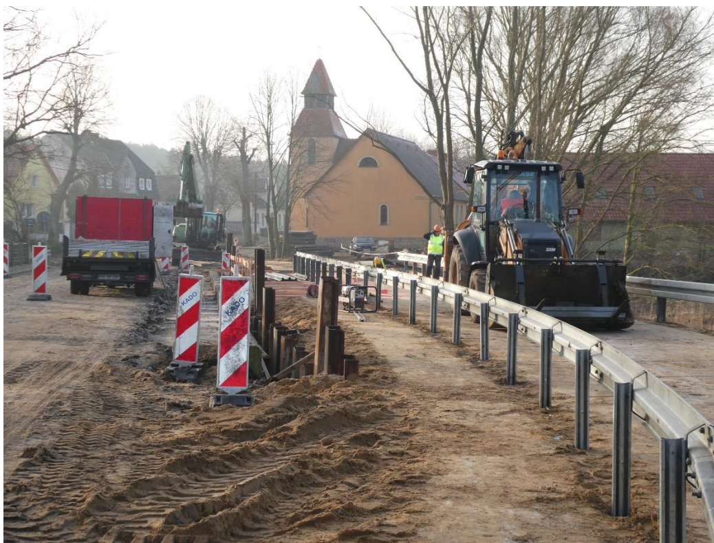
Zdjęcie 2. Most w Żółwinie. Budowa przeprawy tymczasowej. Stan zaawansowania prac na 25.02.2021 r.
