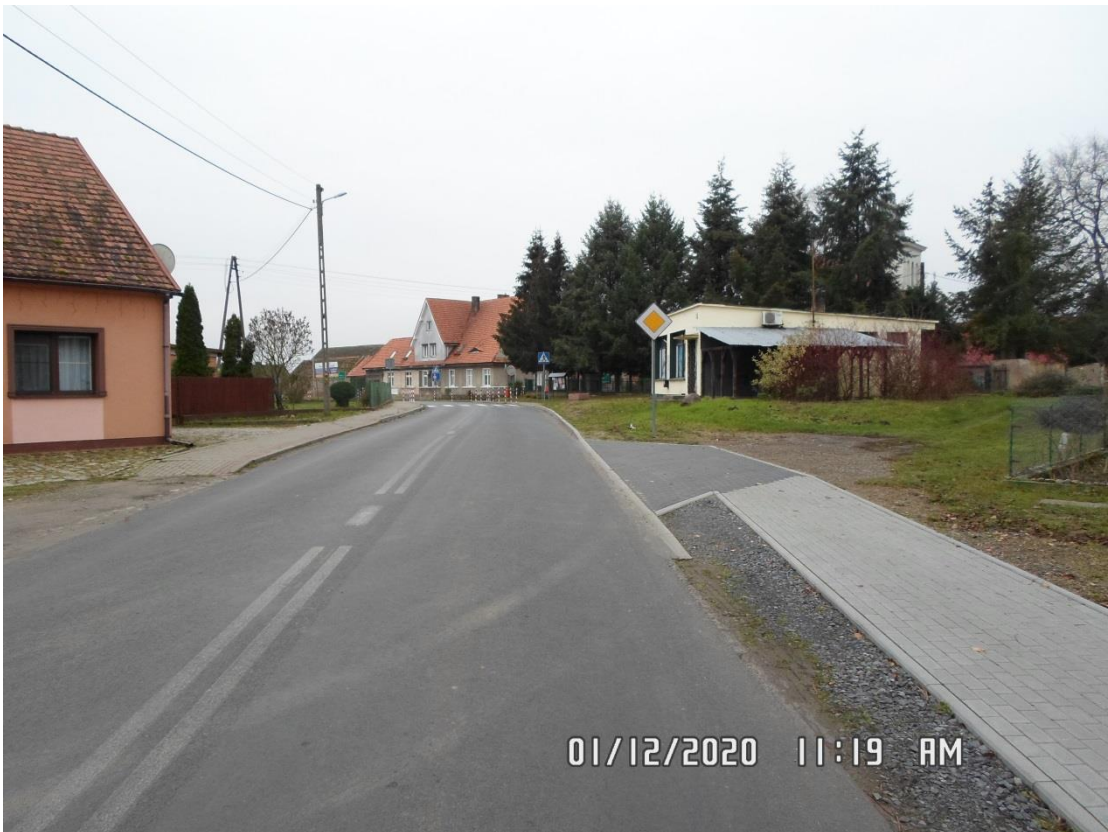
Zdjęcie 16. Przebudowa drogi powiatowej nr 1295F w m. Zemsko
