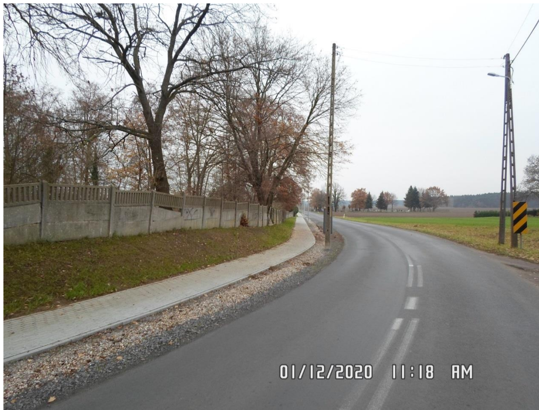
Zdjęcie 17. Przebudowa drogi powiatowej nr 1295F w m. Zemsko
