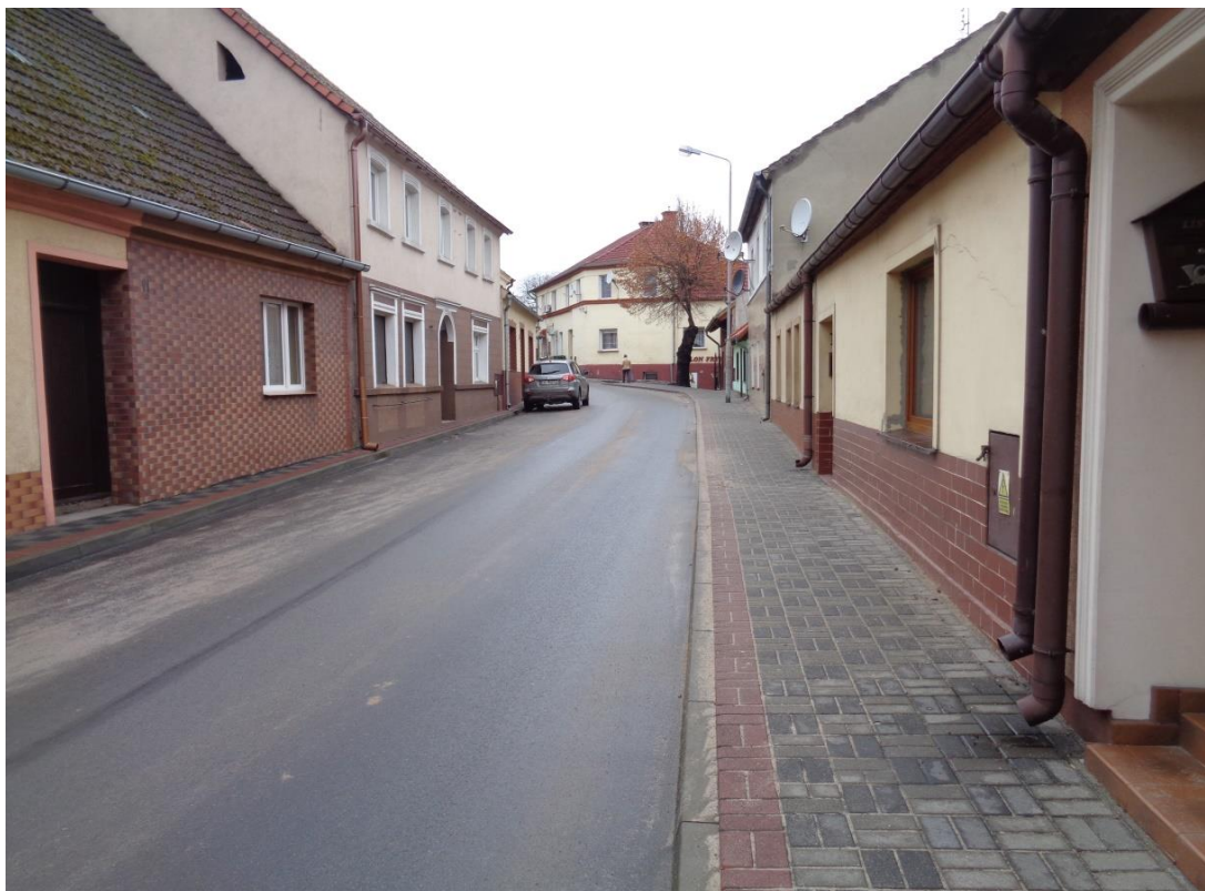
Zdjęcie 15. Remont drogi powiatowej nr 1332F w m. Pszczew – ul. Poznańska
