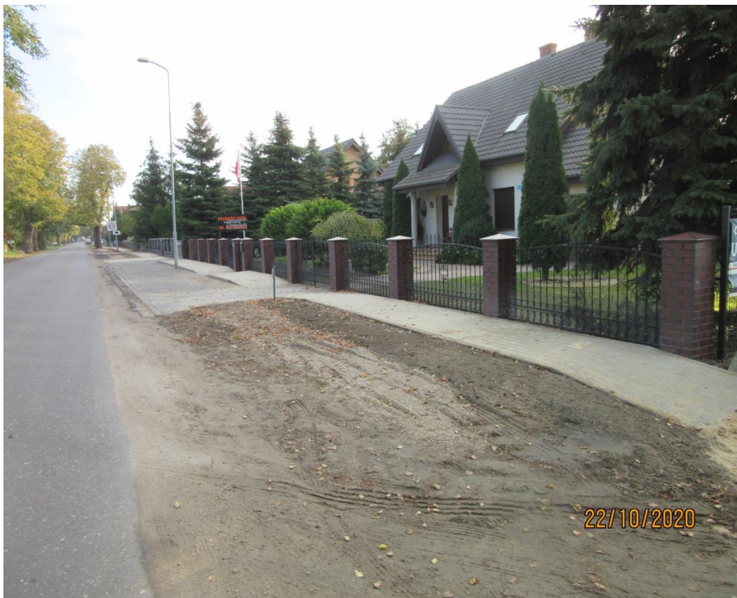
Zdjęcie 23. Przebudowa drogi powiatowej nr 1358F w m. Trzciel ul. Główna
