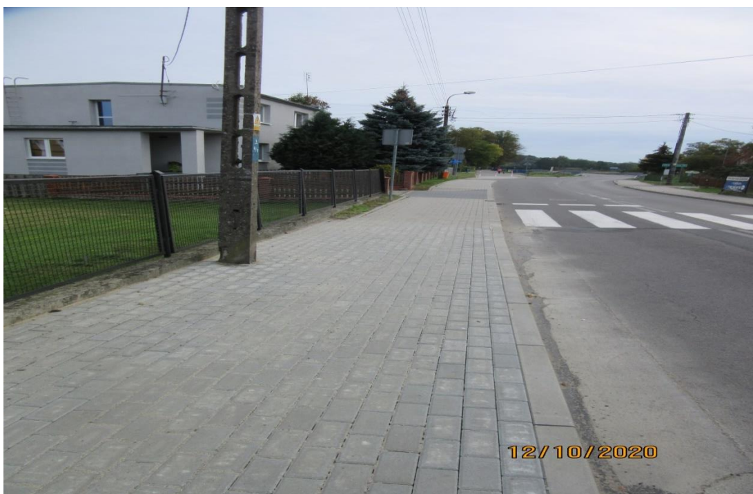
Zdjęcie 20. Przebudowa drogi powiatowej nr 1295F w m. Bledzew ul. Sportowa
