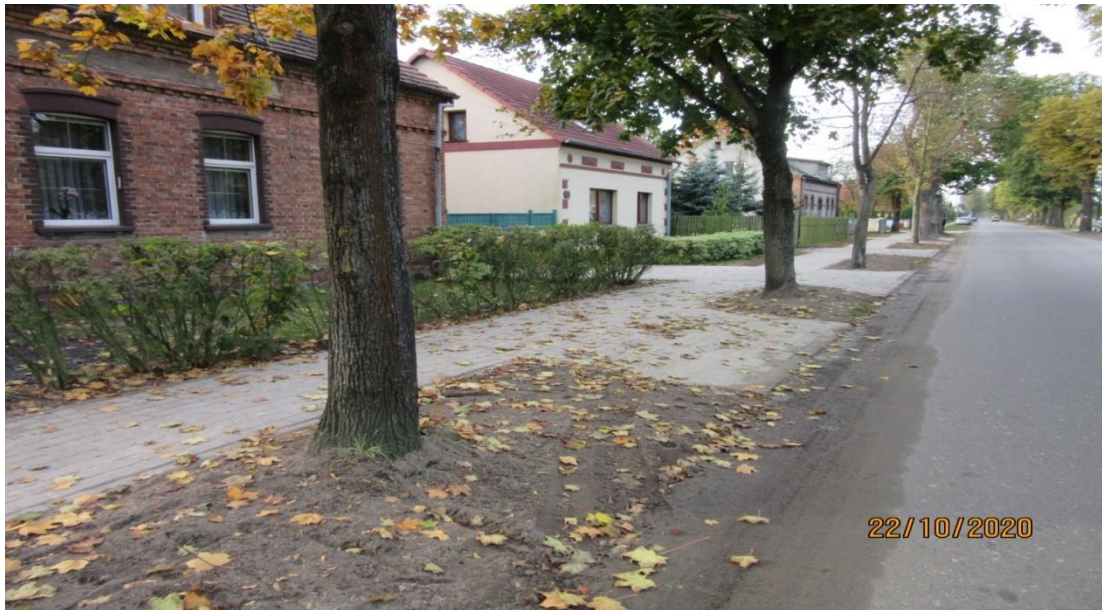
Zdjęcie 21. Przebudowa drogi powiatowej nr 1358F w m. Trzciel ul. Główna
