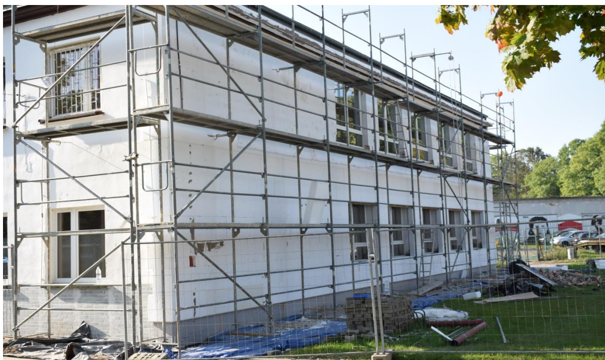
Zdjęcie 4. Prace Remontowe stan na dzień 22.09.2020 - budynek CKZiU ul. Marcinkowskiego
