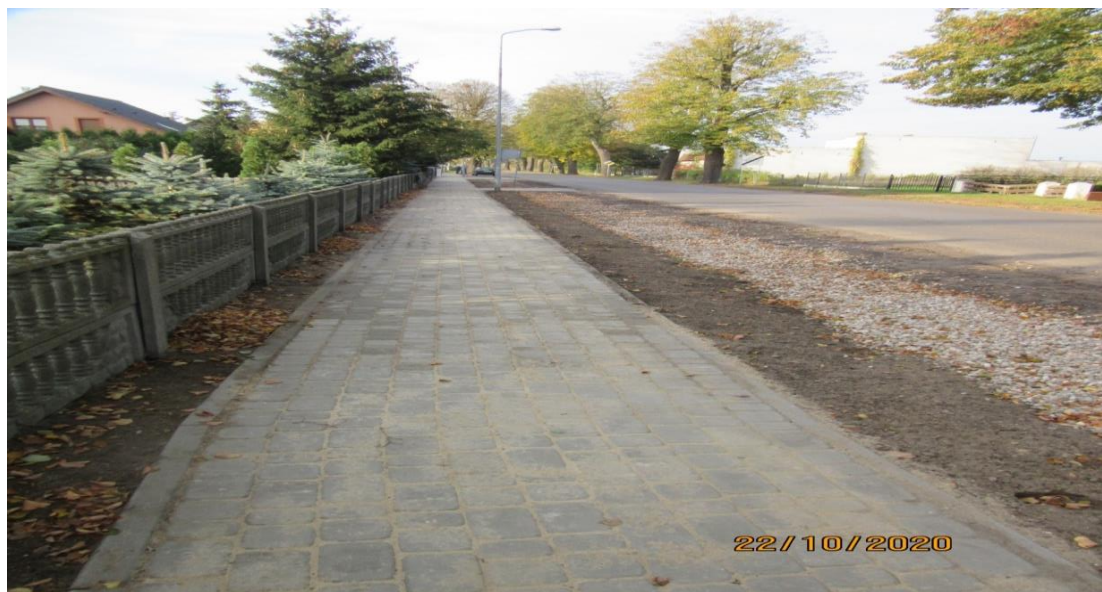
Zdjęcie 22. Przebudowa drogi powiatowej nr 1358F w m. Trzciel ul. Główna
