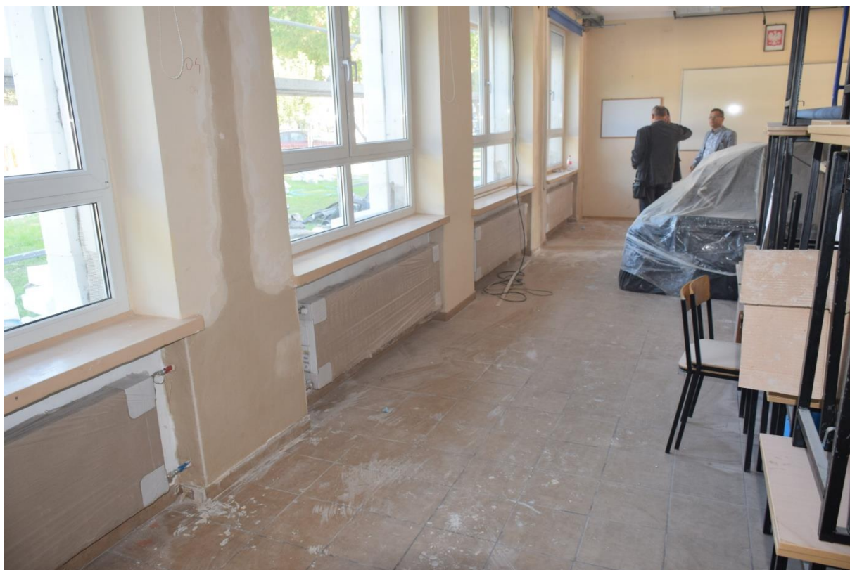
Zdjęcie 7. Prace Remontowe stan na dzień 22.09.2020 - budynek CKZiU ul. Marcinkowskiego.
