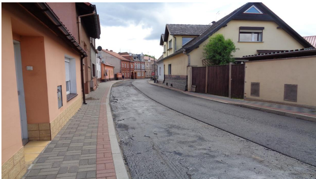
Zdjęcie 13. Remont drogi powiatowej nr 1332F w m. Pszczew – ul. Poznańska
