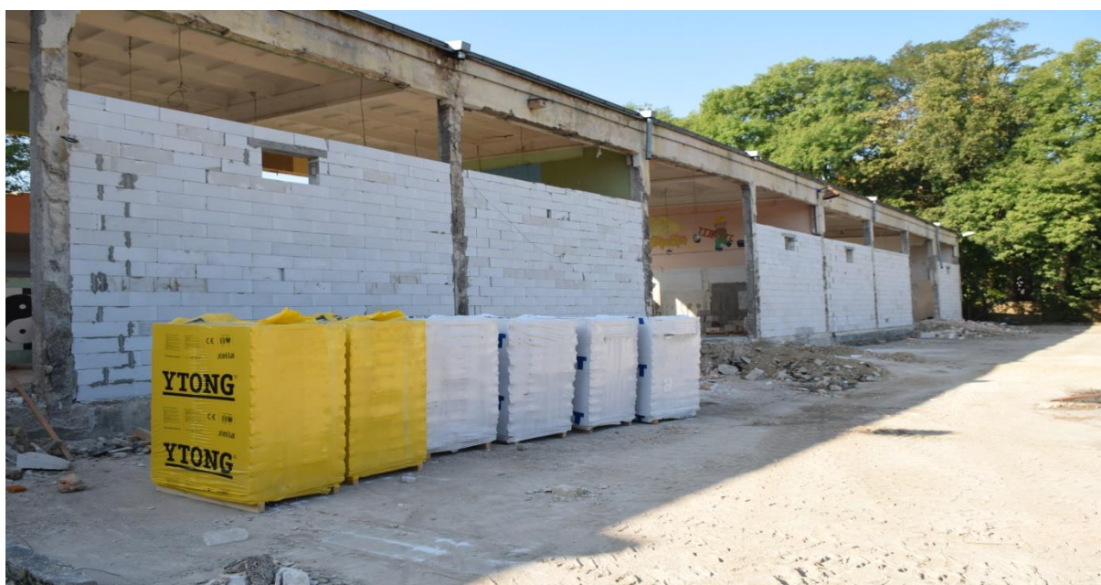
Zdjęcie 5. Prace Remontowe stan na dzień 22.09.2020 - budynek warsztatów CKZiU ul. Marcinkowskiego
