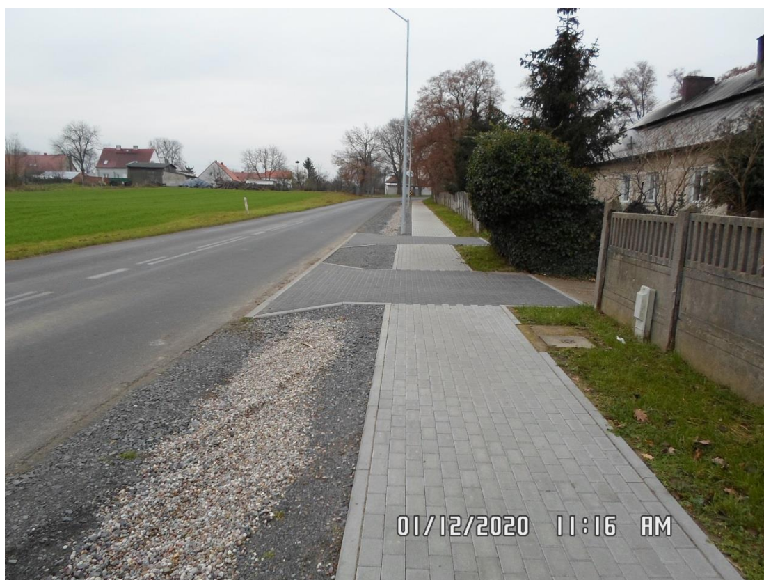
Zdjęcie 18. Przebudowa drogi powiatowej nr 1295F w m. Zemsko
