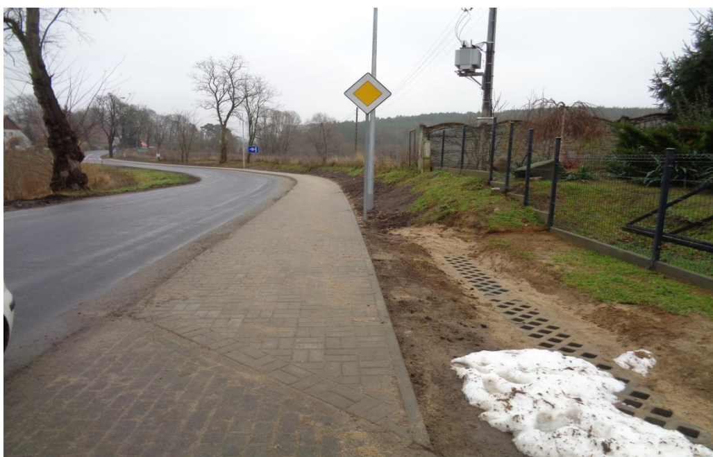
Zdjęcie: Przebudowa drogi powiatowej nr 1337F w m. Pszczew ul. Kasztanowa – 2021 r.
