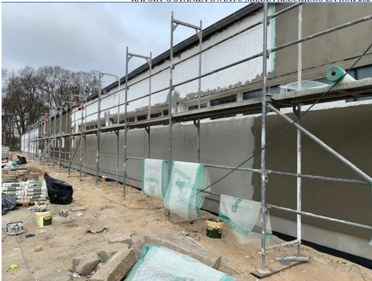
Zdjęcie: Remont budynku warsztatów Technikum nr 2 w Międzyrzeczu.
