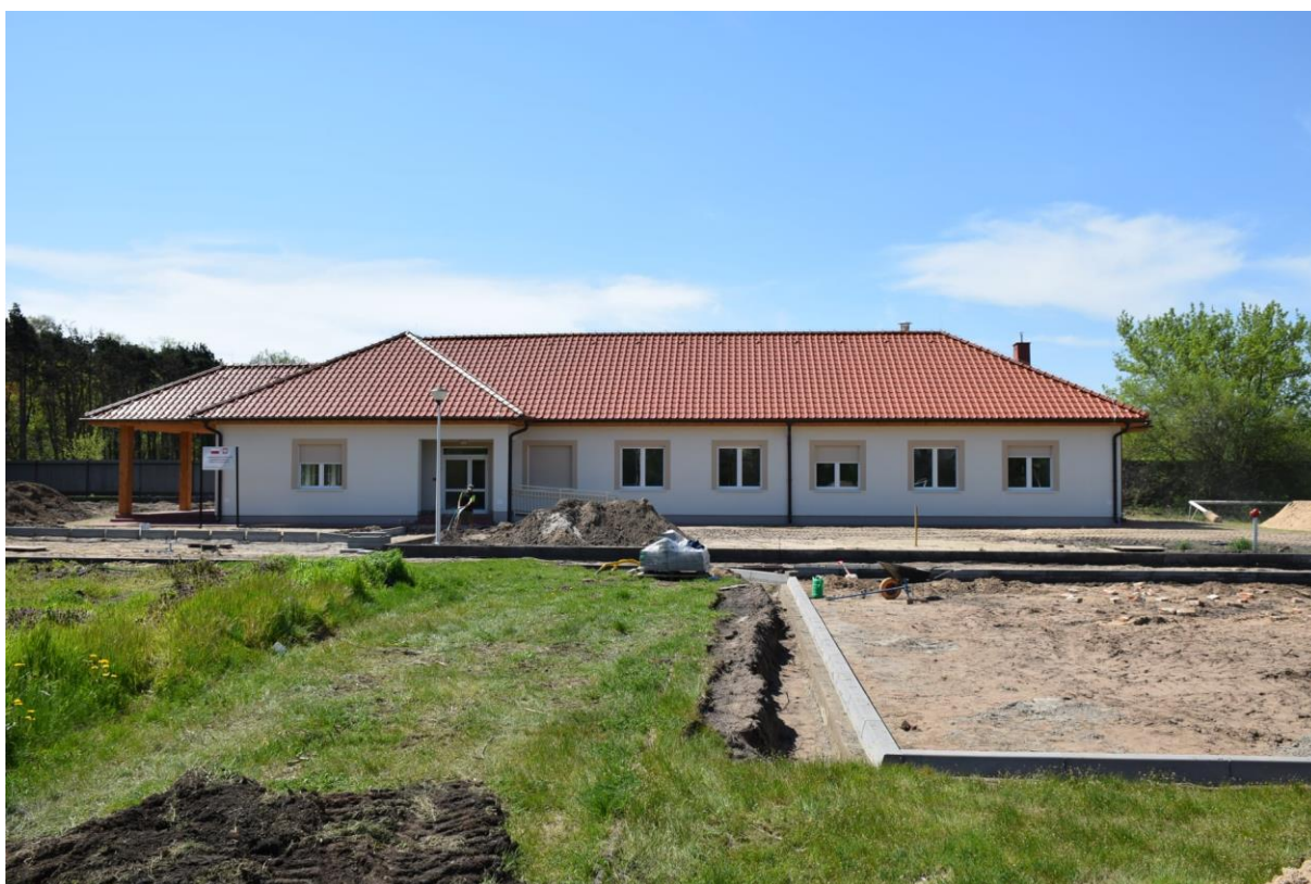
Zdjęcie: Budowa nowego Domu Dziecka w Skwierzynie – czerwiec 2021 r.
