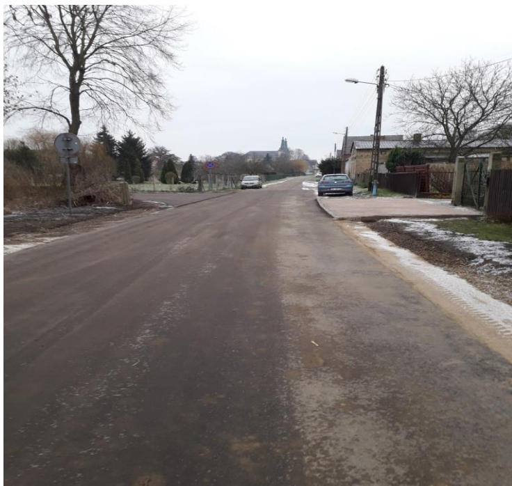
Zdjęcie: Przebudowa drogi powiatowej nr 1320F w m. Rokitno – 2021 r.
