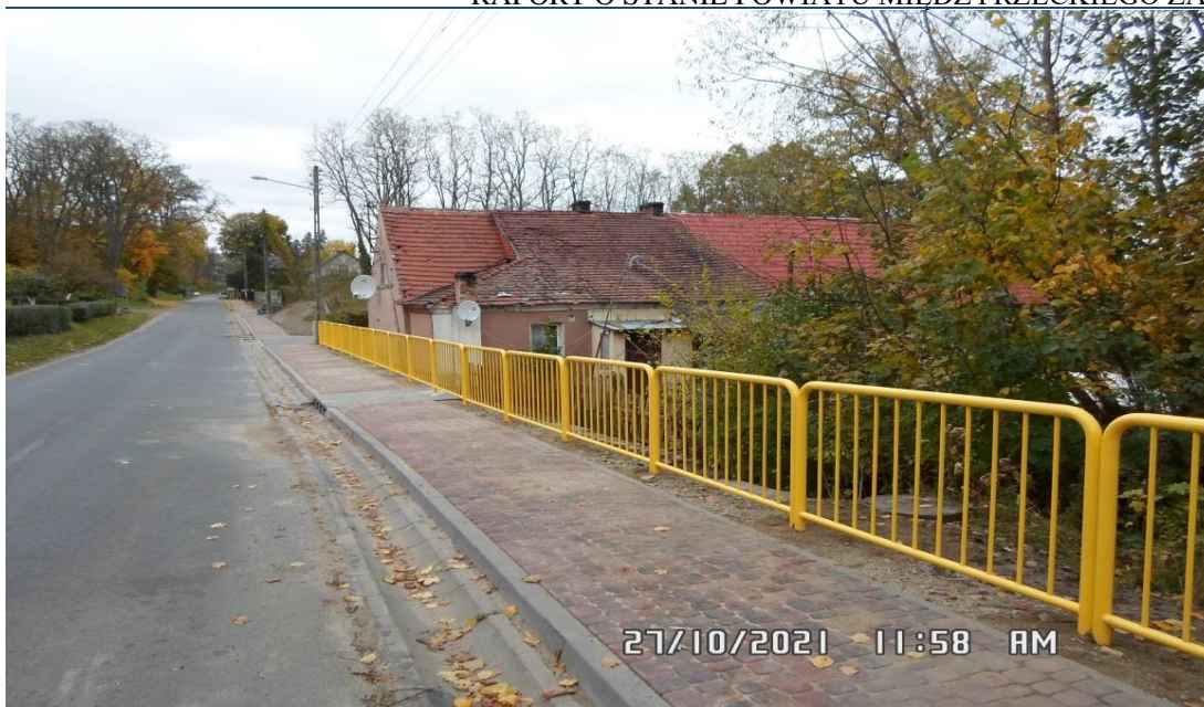
Zdjęcie: Przebudowa drogi powiatowej nr 1341F w m. Kursko – październik 2021 r.
