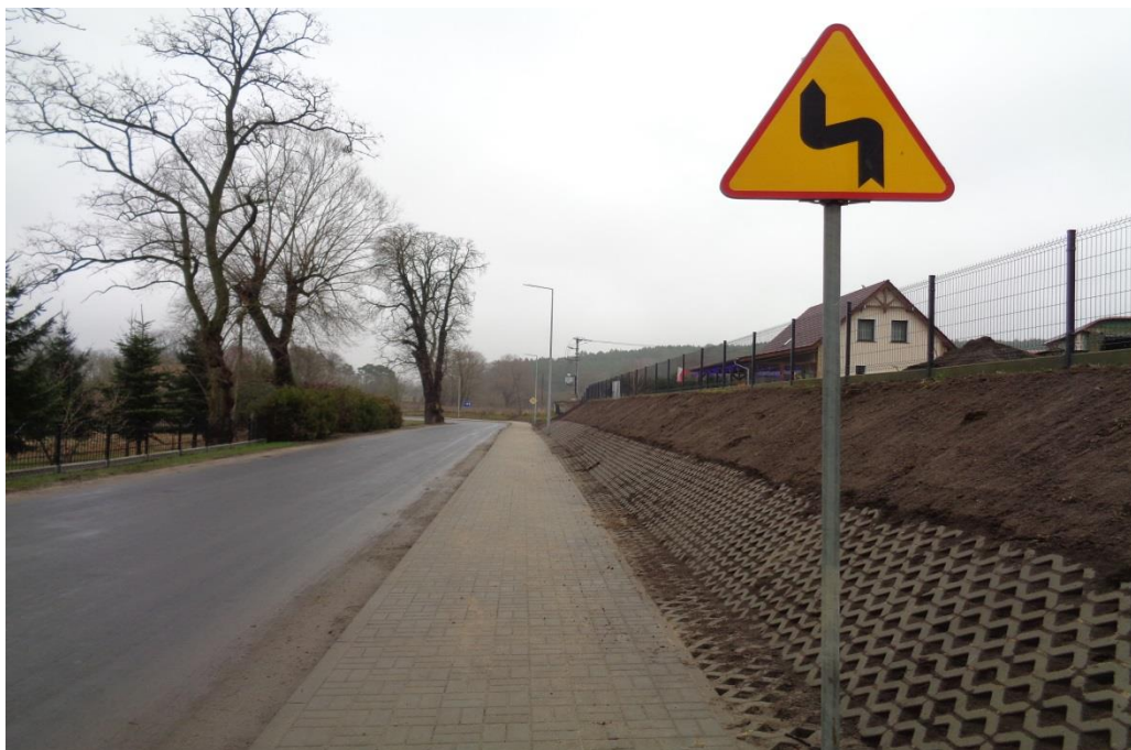
Zdjęcie: Przebudowa drogi powiatowej nr 1337F w m. Pszczew ul. Kasztanowa – 2021 r.
