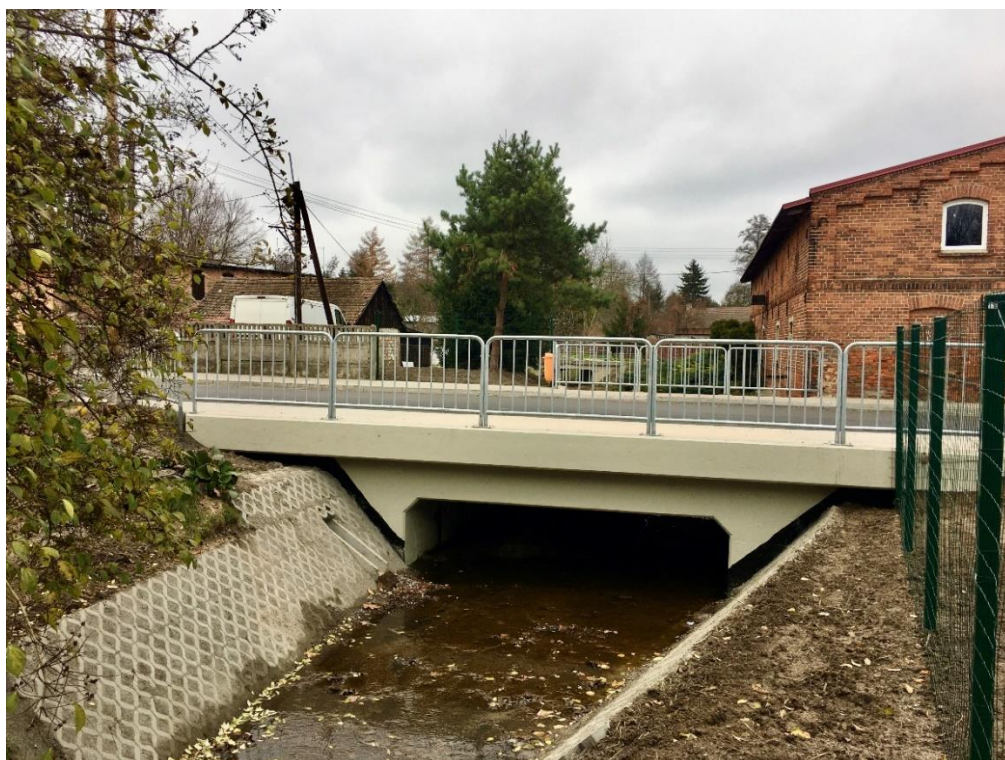
Zdjęcie: Przepust – JNI – F00129500001 w m. Bledzew – 2021r.
