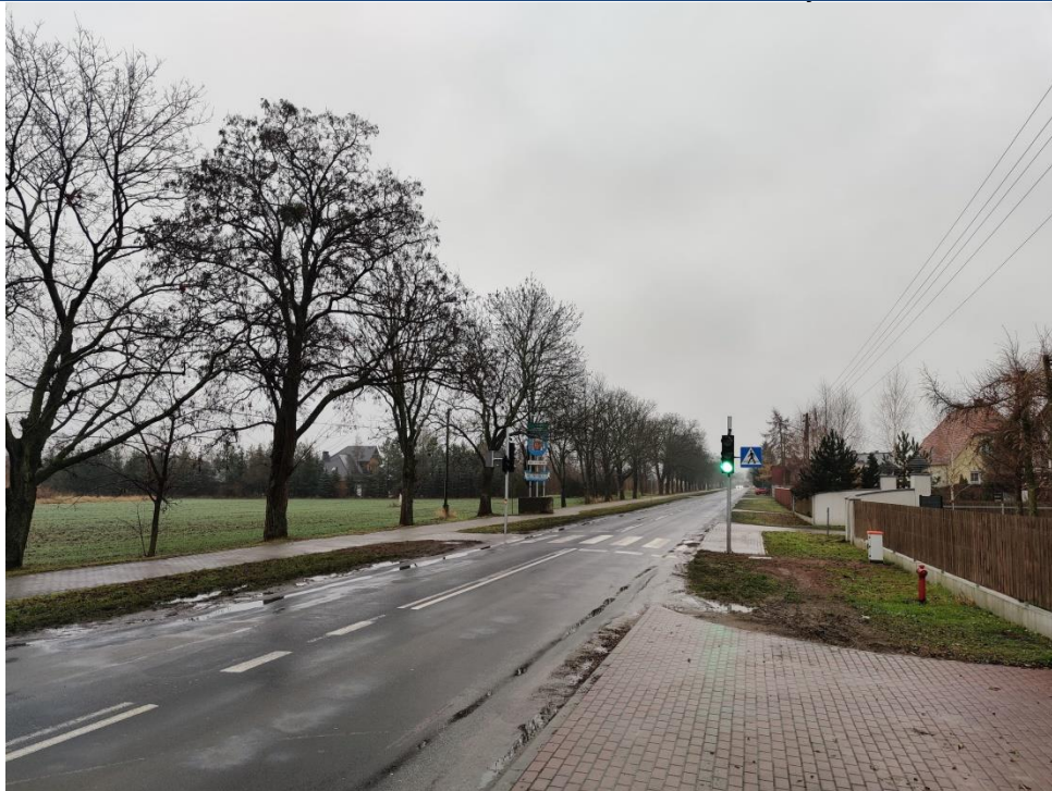
Zdjęcie: Budowa sygnalizatorów świetlnych z detekcją – 2021 r.
