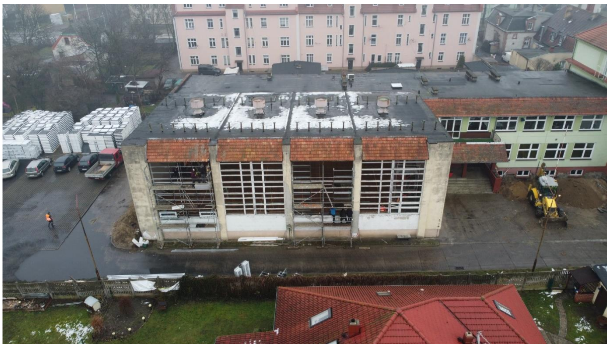
Zdjęcie: Remont budynku Technikum nr 1 – sali gimnastycznej i łącznika – luty 2021 r.
