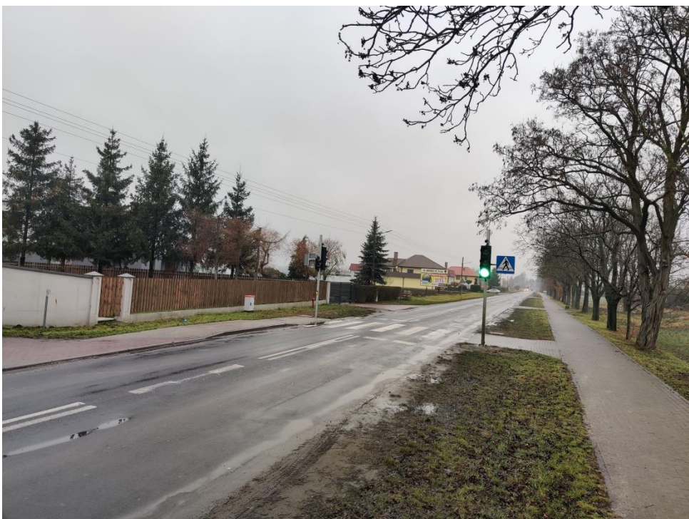
Zdjęcie: Budowa sygnalizatorów świetlnych z detekcją – 2021 r.
