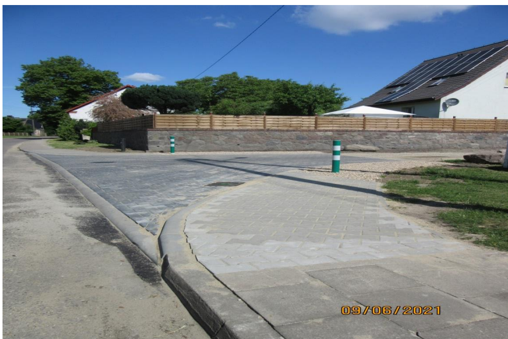
Zdjęcie: Remont drogi powiatowej nr 1213F w m. Lutol Suchy – czerwiec 2021 r.
