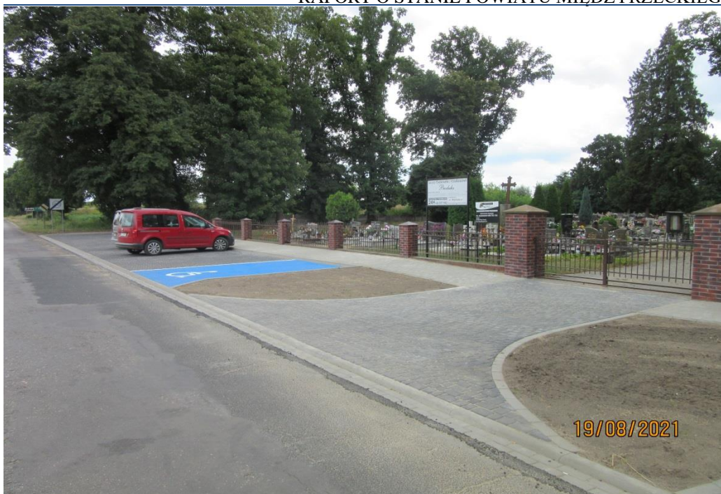
Zdjęcie: Przebudowa drogi powiatowej nr 1358F w m. Trzciel ul. Graniczna – sierpień 2021 r.
