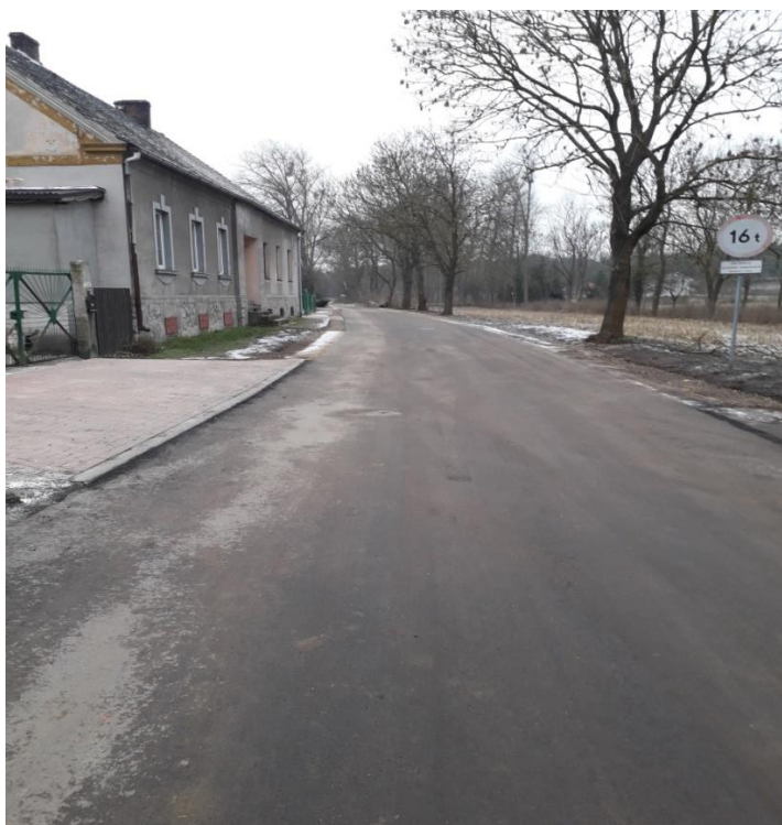
Zdjęcie: Przebudowa drogi powiatowej nr 1320F w m. Rokitno – 2021 r.
