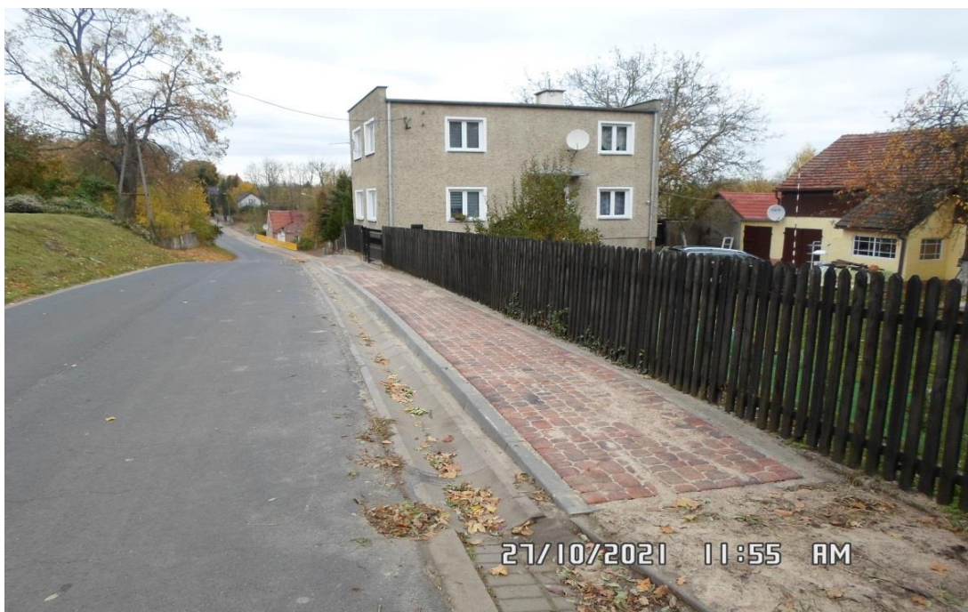
Zdjęcie: Przebudowa drogi powiatowej nr 1341F w m. Kursko – październik 2021 r.
