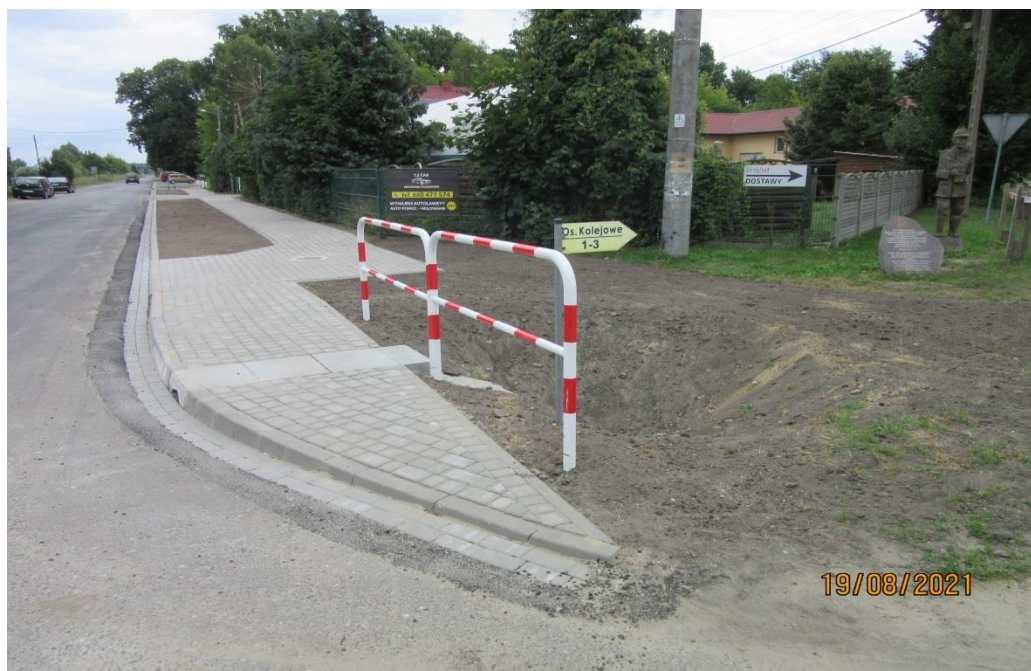
Zdjęcie: Przebudowa drogi powiatowej nr 1358F w m. Trzciel ul. Graniczna – sierpień 2021r
