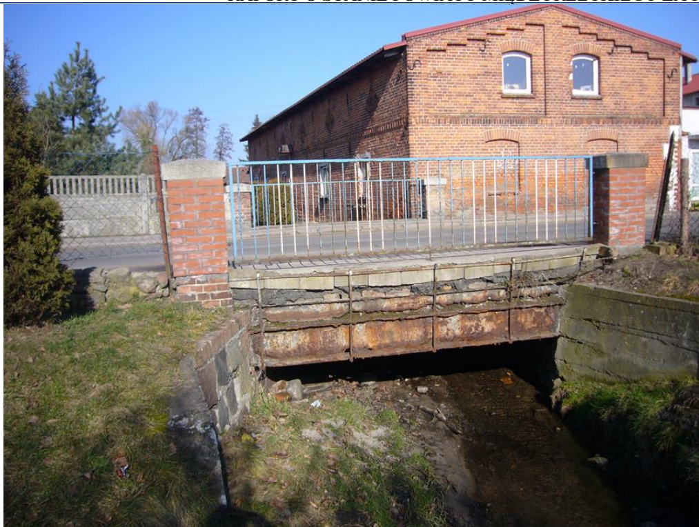
Zdjęcie: Przepust – JNI – F00129500001 w m. Bledzew – 2020 r.
