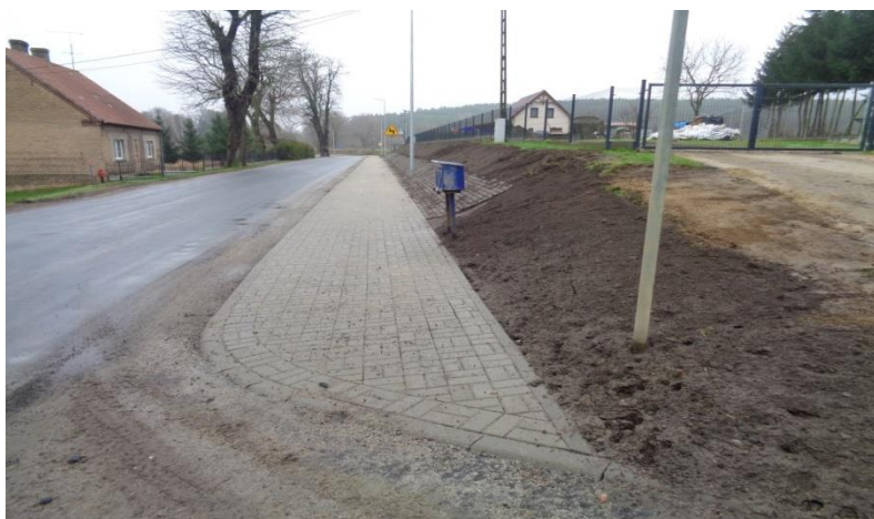
Zdjęcie: Przebudowa drogi powiatowej nr 1337F w m. Pszczew ul. Kasztanowa – 2021 r.
