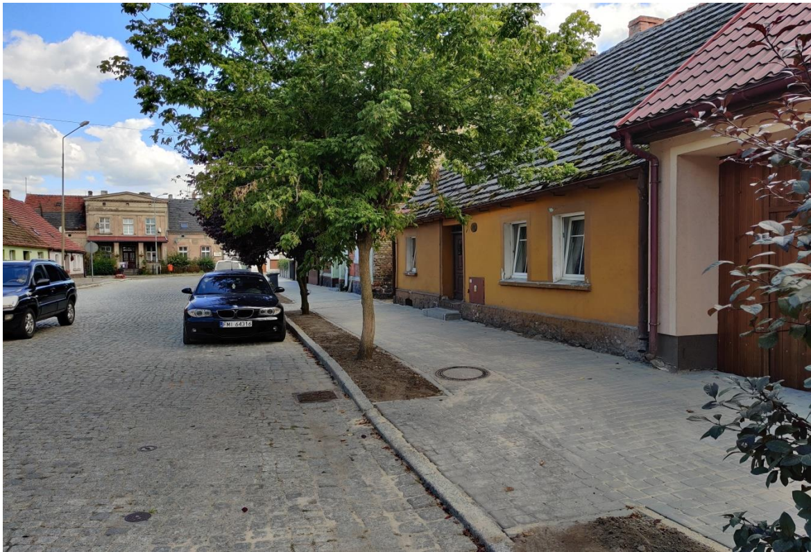
Zdjęcie: Przebudowa drogi powiatowej nr 1358F w m. Trzciel ul. Graniczna
