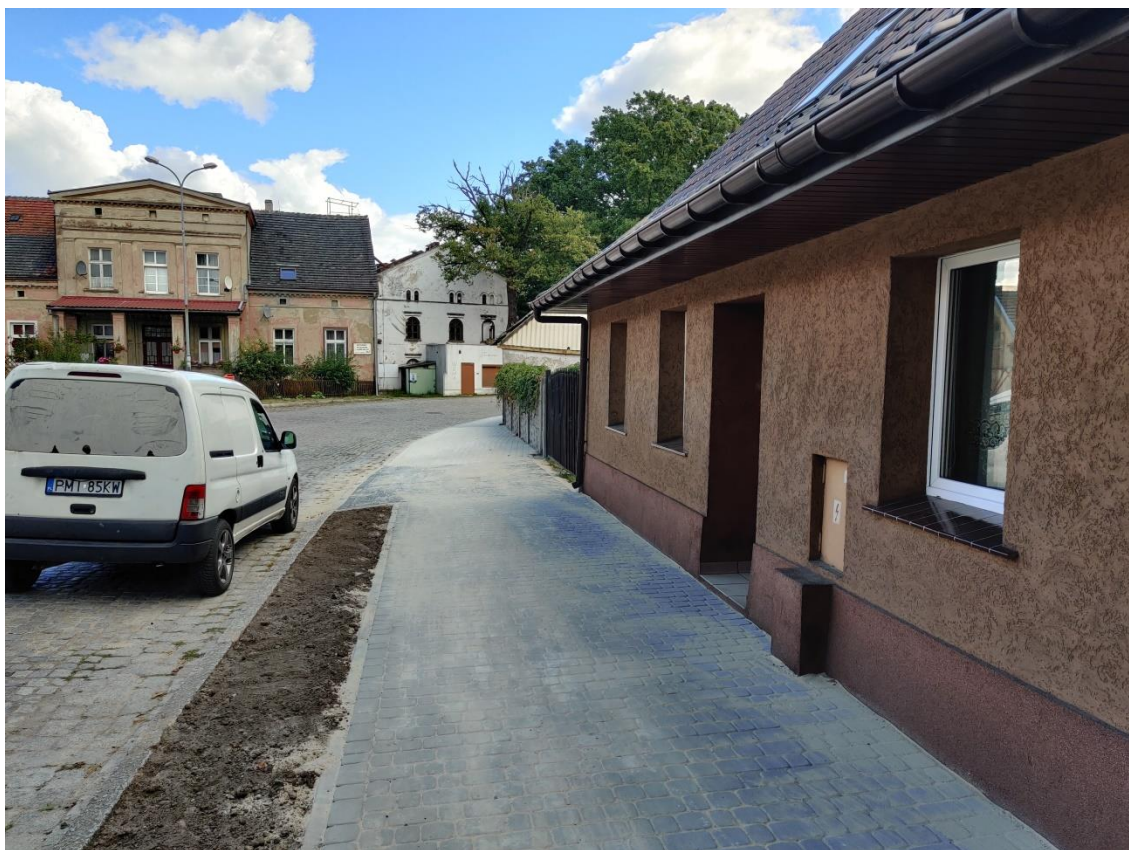
Zdjęcie: Przebudowa drogi powiatowej nr 1358F w m. Trzciel ul. Graniczna
