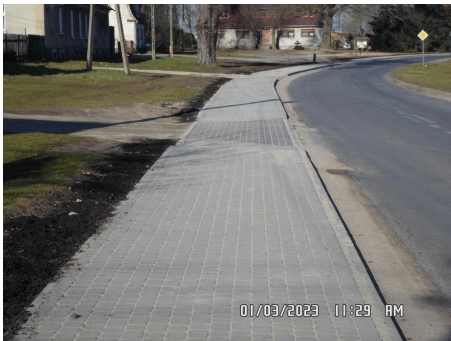
Zdjęcie: Przebudowa drogi powiatowej nr 1295F w m. Sokola Dąbrowa
