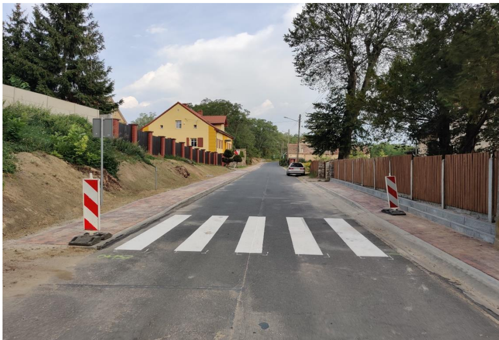
Zdjęcie: Przebudowa drogi powiatowej nr 1341F w m. Kursko
