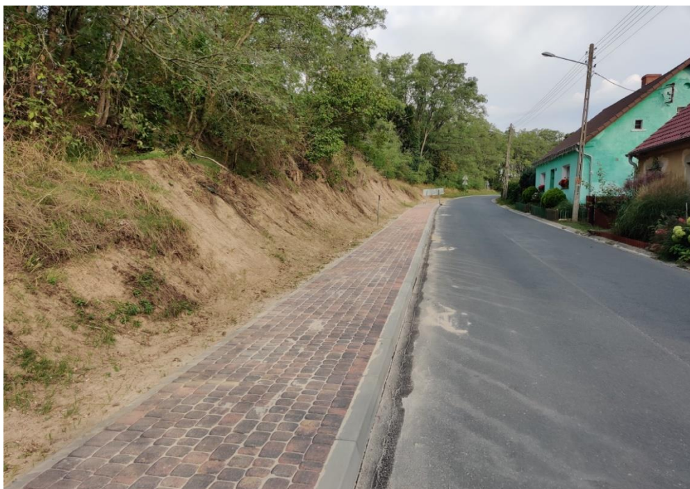
Zdjęcie: Przebudowa drogi powiatowej nr 1341F w m. Kursko
