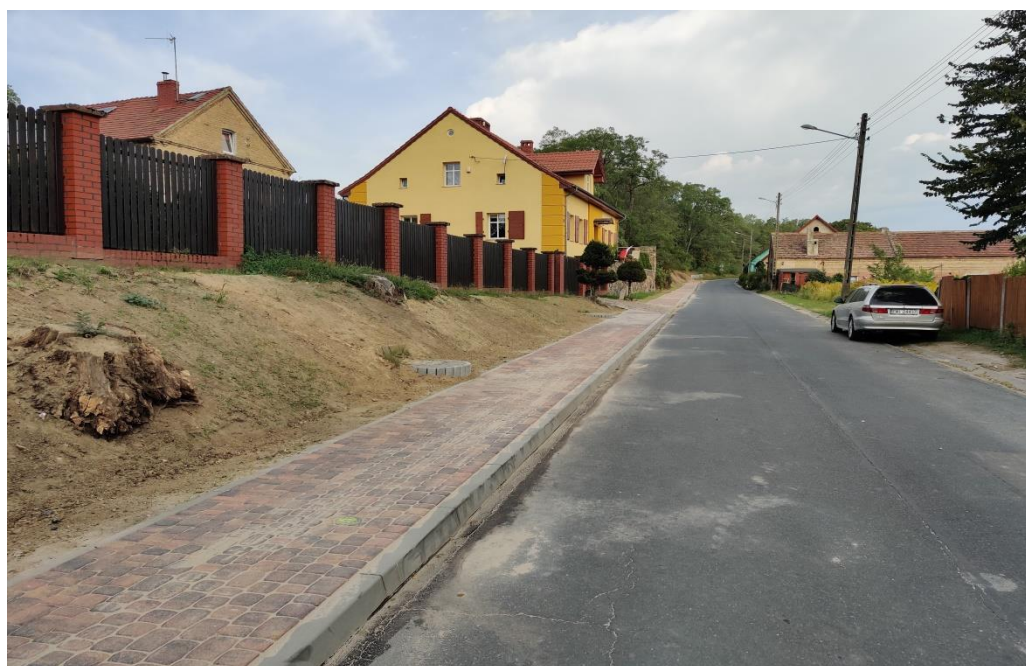
Zdjęcie: Przebudowa drogi powiatowej nr 1341F w m. Kursko
