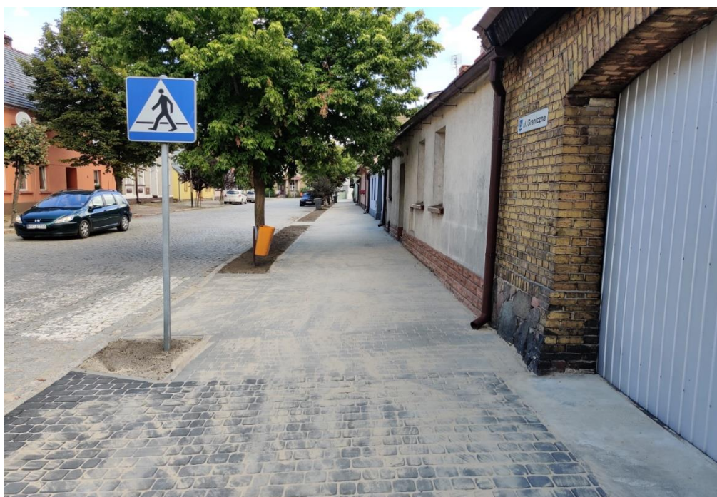
Zdjęcie: Przebudowa drogi powiatowej nr 1358F w m. Trzciel. ul. Graniczna
