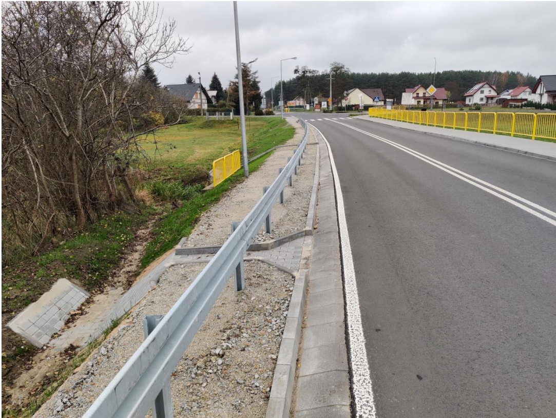
Zdjęcie: Przebudowa drogi powiatowej nr 1332F ul. Międzyrzecka w m. Pszczew
