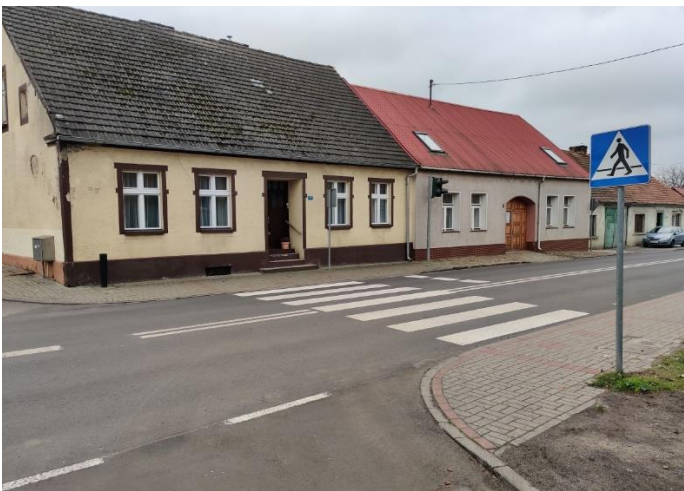
Zdjęcie: Przebudowa drogi powiatowej nr 1332F ul. Międzyrzecka w m. Pszczew
